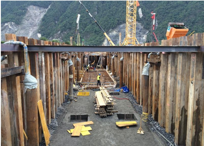
Rabattement de la nappe et enceinte de fouille cellule num. 5
