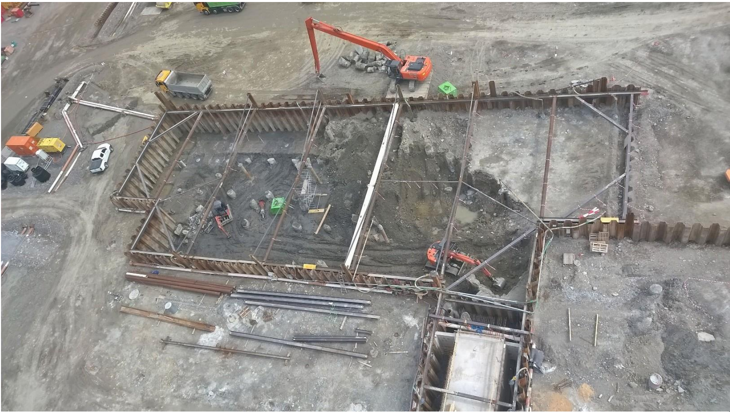
Situation cellule num. 1, palplanches et puits de pompage
