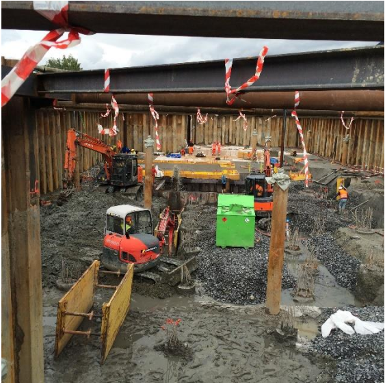
Petite palplanches en fond de fouille, cellule 1
